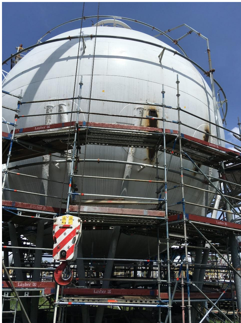
Obr. 10 Výmena nôh guľového zásobníka (nádrž č. 3)
