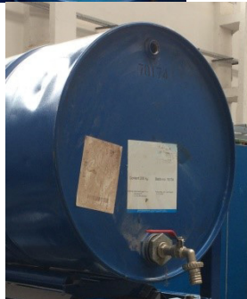
Obr. 4 Nevýhovující skladování olejů – olej není nijak chráněn proti kontaminaci
