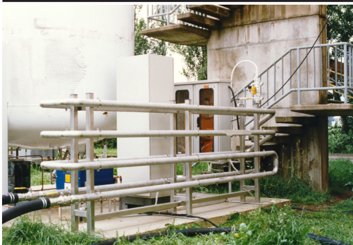
Obr. 6 Príklad realizácie rúrkového neutralizačného reaktora
