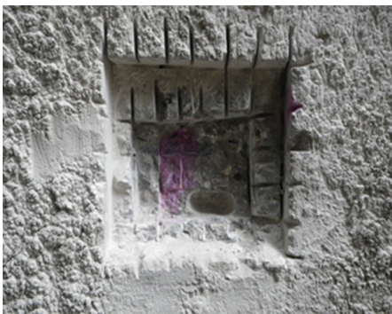
Obr. 3 Zisťovanie hĺbky karbonatácie priamo na drieku sila
