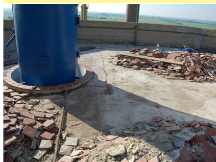
Obr. 3 Hydroizolačné vlastnosti strechy zabezpečovala iba keramická dlažba, ktorá bola v dezolátnom stave
