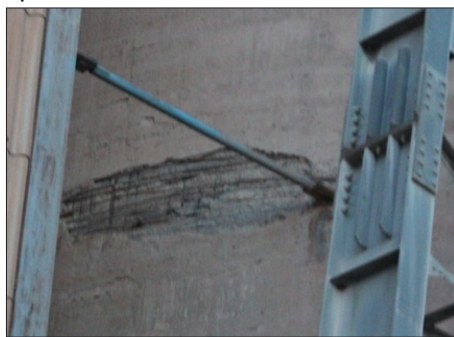
Obr. 1 Vizuálne identifikovateľné defekty na vonkajšom drieku
