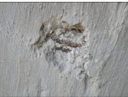
Obr. 1 Vizuálne identifikovateľné defekty na vonkajšom drieku
