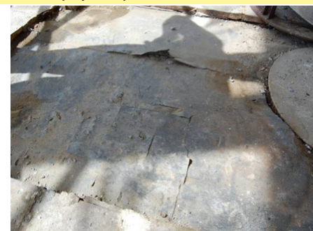
Obr. 4 Hydroizolácia technologického podlažia bola v dezolátnom stave
