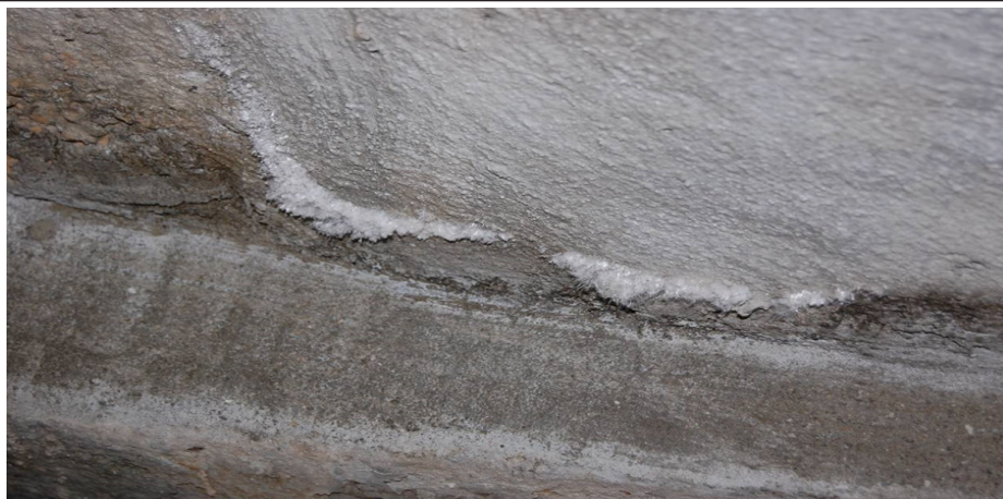
Obr. 6 Výkvetvy močoviny bezprostredne po sanácii
