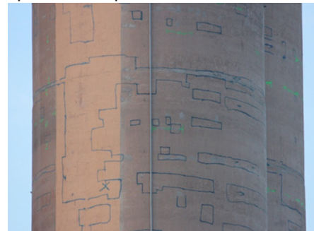
Obr. 5 Vizualná obhliadka drieku sil, označenie defektov
