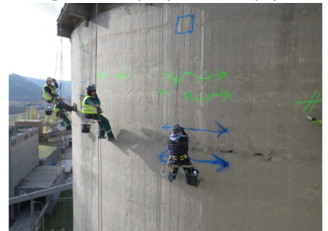
Obr. 5 Vizualná obhliadka drieku sil, označenie defektov
