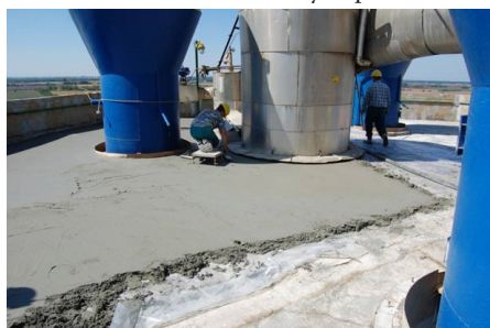
Obr. 7 Zhotovenie novej spádovej vrstvy, betón C16/20 fr. 0-4mm
