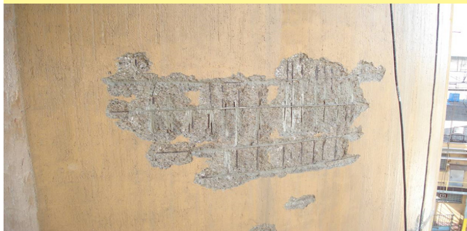
Obr. 2 Rozsah plošného poškodenia, ktorý sa zväčša ukáže až po akustickom trasovaní a mechanickým odstránení uvoľnených častí krycej vrstvy betónu
