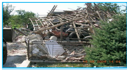
Obr. 4 Deštrukcia rodinného domu 2008
