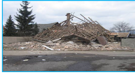
Obr. 3 Deštrukcia rodinného domu 2010
