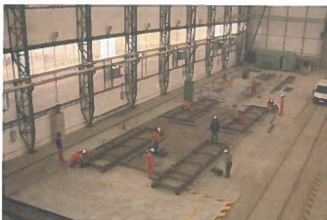
Príprava pomocných konštrukcií k výrobe modulov
