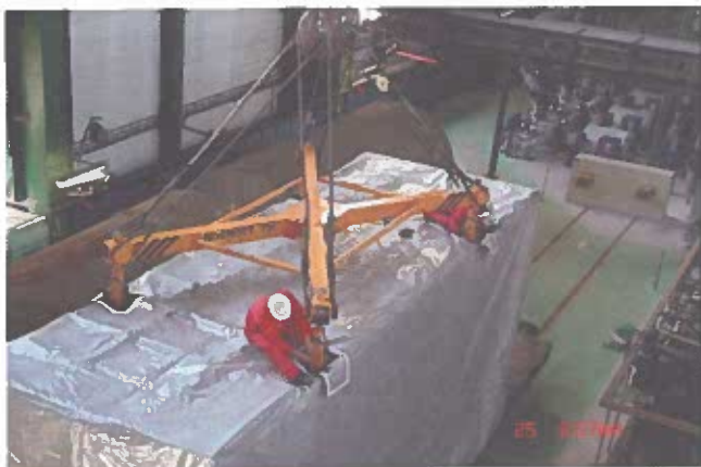
Transport nového modulu pracovníkmi oddelenia realizácie údržby točivých strojov
