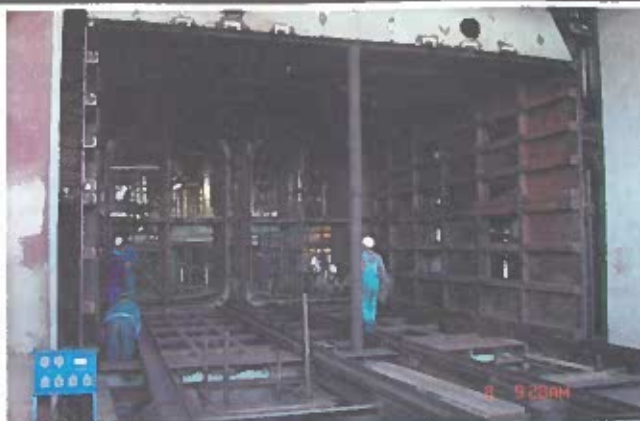
Pohľad do vnútorných priestorov plášťa HK po zdemontovaní pôvodných trubkových zväzkov
