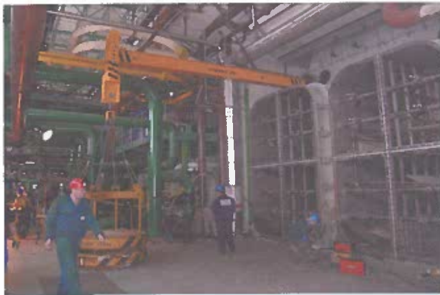
Spätná montáž vodných komôr
