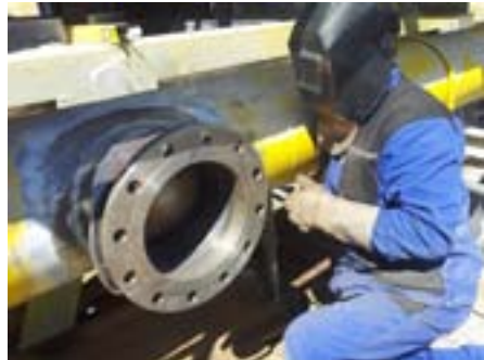
Obr. 10 Zváranie hrdla na potrubie „za prevádzky“
