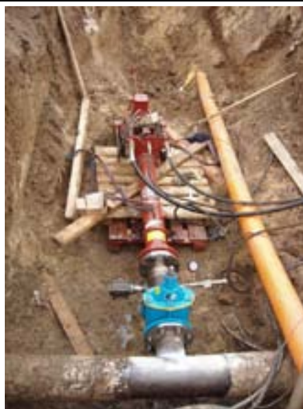
Obr. 12 Prevŕtanie potrubia
