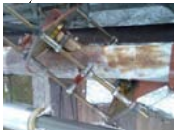
Obr. 5 Inštalácia ultrazvukových prietokomerov
