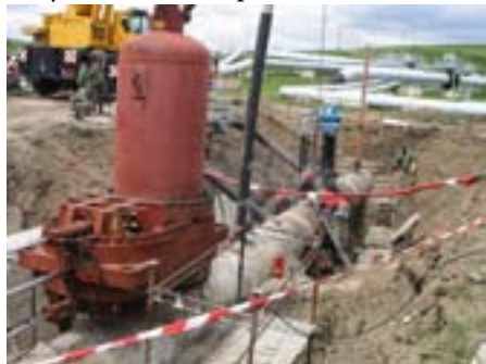
Obr. 9 Výmena nevyhovujúceho uzáveru DN700
