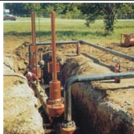
Obr. 14 Dvojpolohová uzatváracia operácia s obtokom
