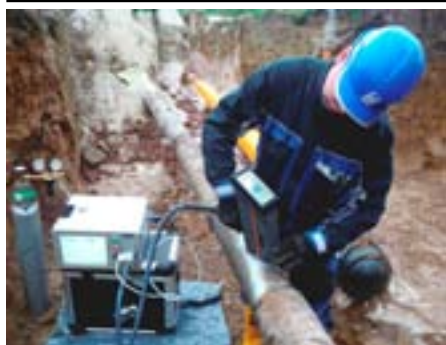
Obr. 11 Vykonanie chemickej analýzy materiálu potrubia v mieste zvárania prenosným spektrálnym analyzátorom
