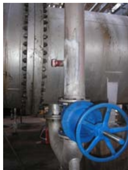
Obr. 7 Nový uzáver vymenený „za prevádzky“
