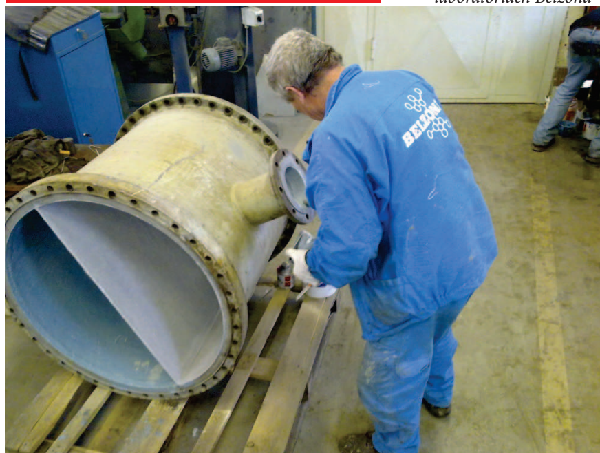
Obr. 8: Opravy komôr a prírub
