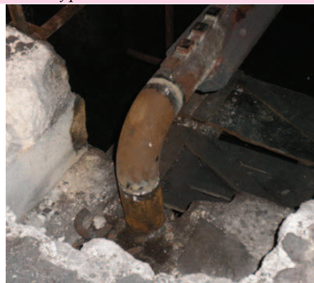
obr. 3 Ukotvenie do steny 4. zóny
