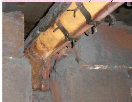
obr. 5 Poškodená izolácia systému sklzníc cca 3 hodiny- viď obr. 9. Vzhľadom k priebehu tlačenia – pri optimálnej prevádzke cca 10 - pokračovanie na strane 9
