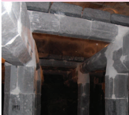
obr. 2 Izolácia systému sklzníc
