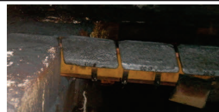
obr. 7 Opatrená izolácia systému sklzníc
