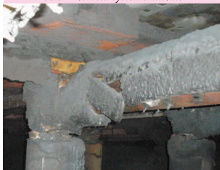
obr. 4 Poškodená izolácia systému sklzníc kmitania) v pásme 0.8 - 1000 Hz. Pri meraní je tento parameter vyhodnocovaný ako priebeh kmitania v sekundových intervaloch po dobu
