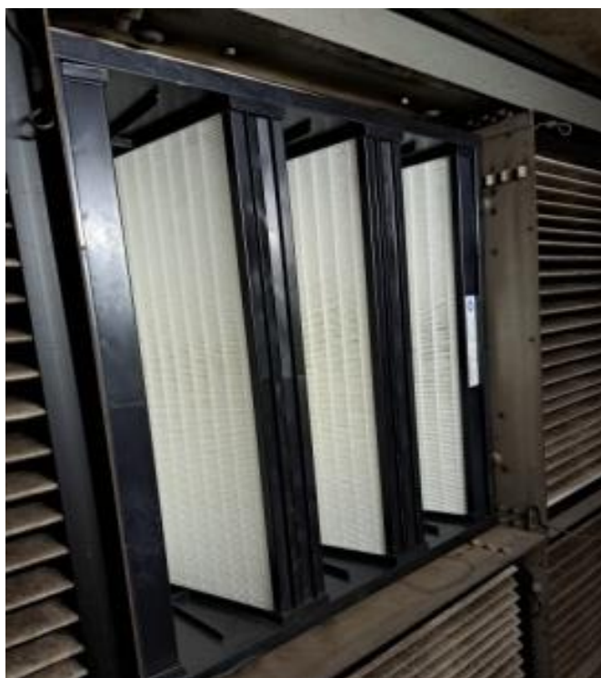
Obr. 2 Výmena filtrov vzduchotechniky vypařovacej pece
