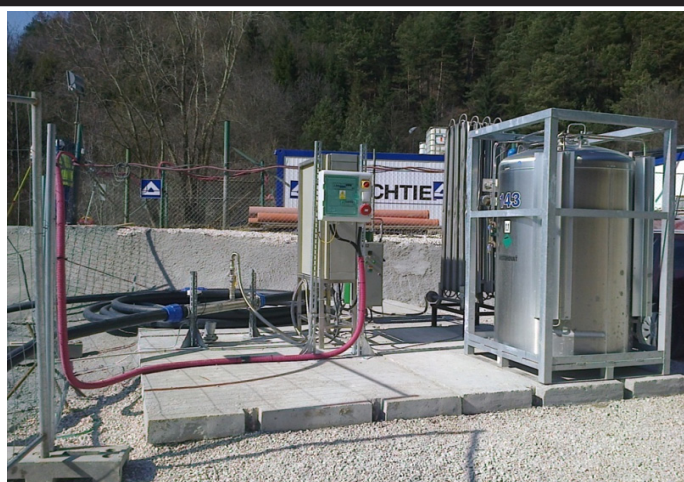
Obr. 7 Príklad mobilnej inštalácie rúrkového neutralizačného reaktora pri razení tunela
