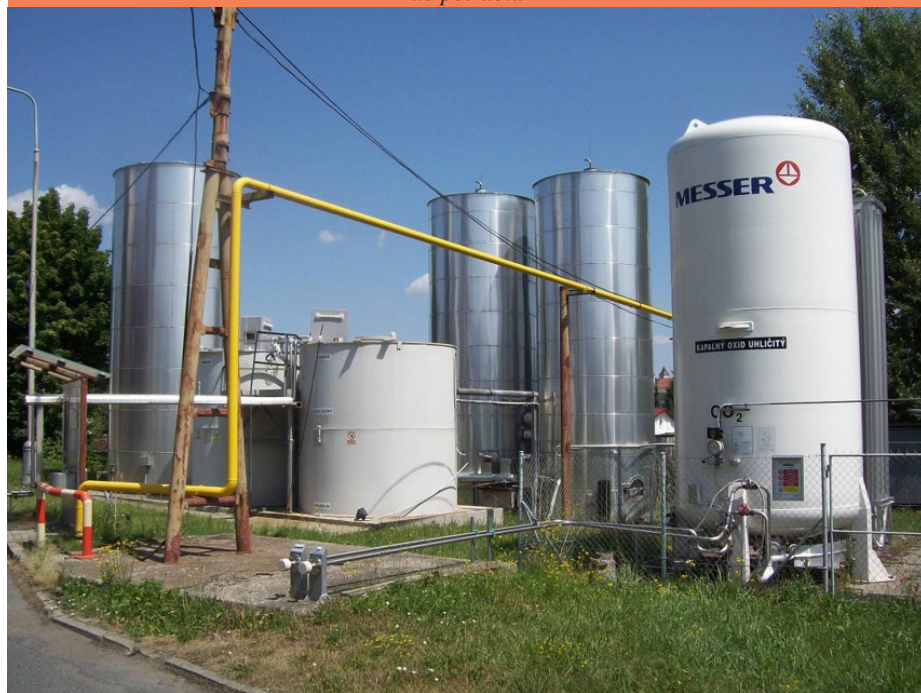
Obr. 4 Príklad inštalácie \text{CO}_2 stanice ako náhrady za \text{H}_2\text{SO}_4 (mliekarne v ČR)
