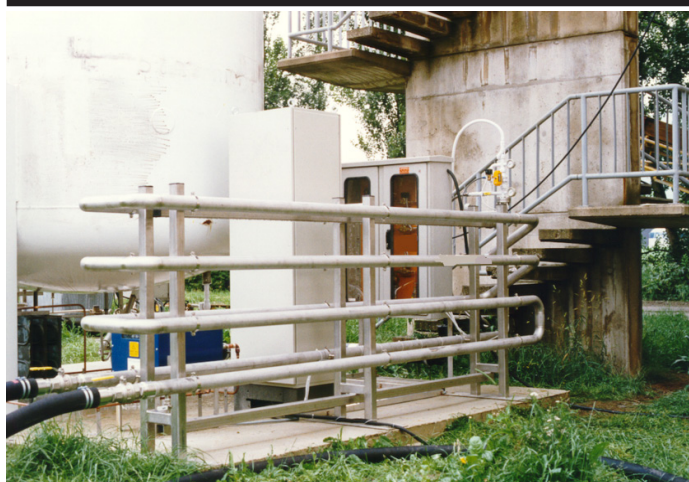
Obr. 6 Príklad realizácie rúrkového neutralizačného reaktora
