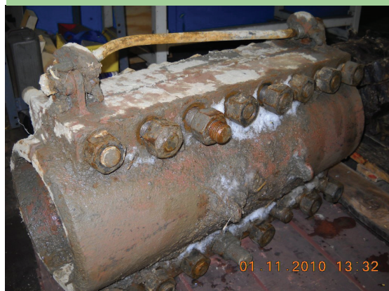
Obr. 19 Delená oceľová objímka po obnove
