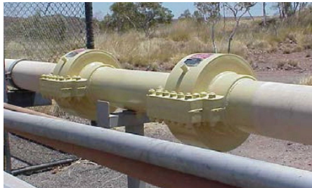
Obr. 14 Prírubové tesniace objímky privarené k potrubiu
