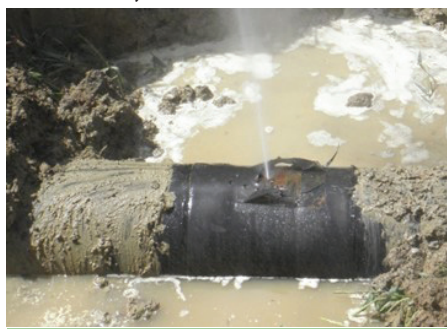
Obr. 7 Bodový únik vody
