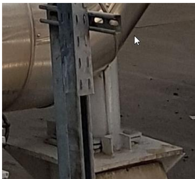
Obr. 9: Detailný pohľad na ukotvenie potrubia [1]
