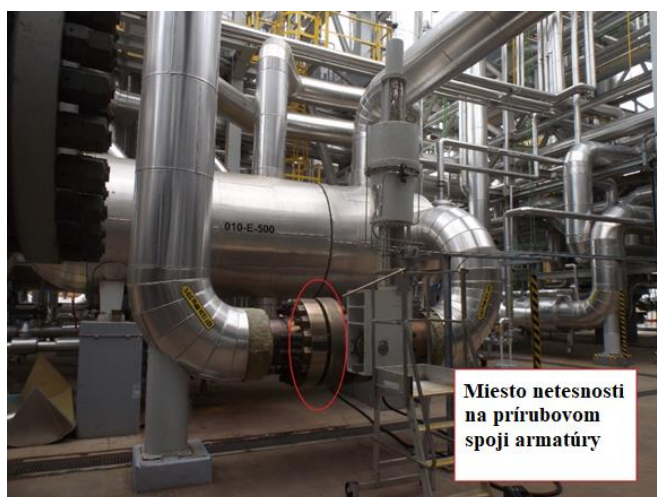
Obr. 17: Pohľad na prírubový spoj armatúry HV-5051 s označením miesta netesnosti [1]
