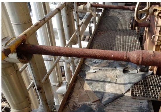
Obr. 1 Typické príklady korózie pod izoláciou
