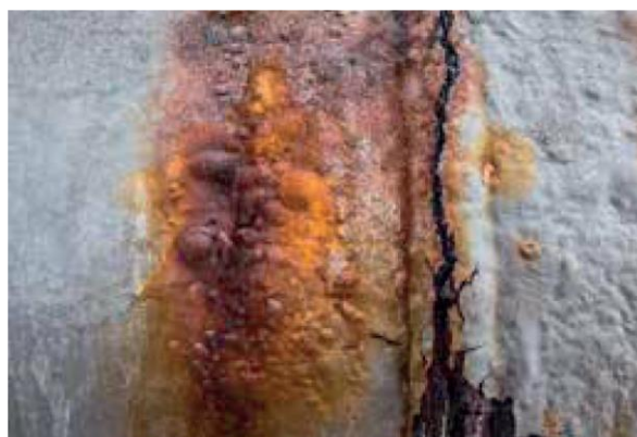
Obr. 12 Veľmi skorodované časti, ktoré nie je možné očistiť
