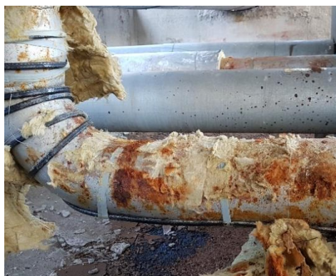
Obr. 1 Typické príklady korózie pod izoláciou
