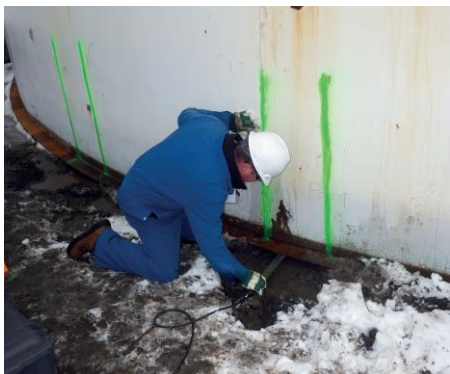
Obr. 17 Meranie obvodového prstenca nádrže
