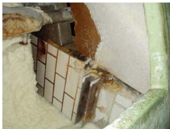
Obr. 1 Priemyselné prostredie s vysokou vlhkosťou a agresívnou atmosférou je označované ako C5.
